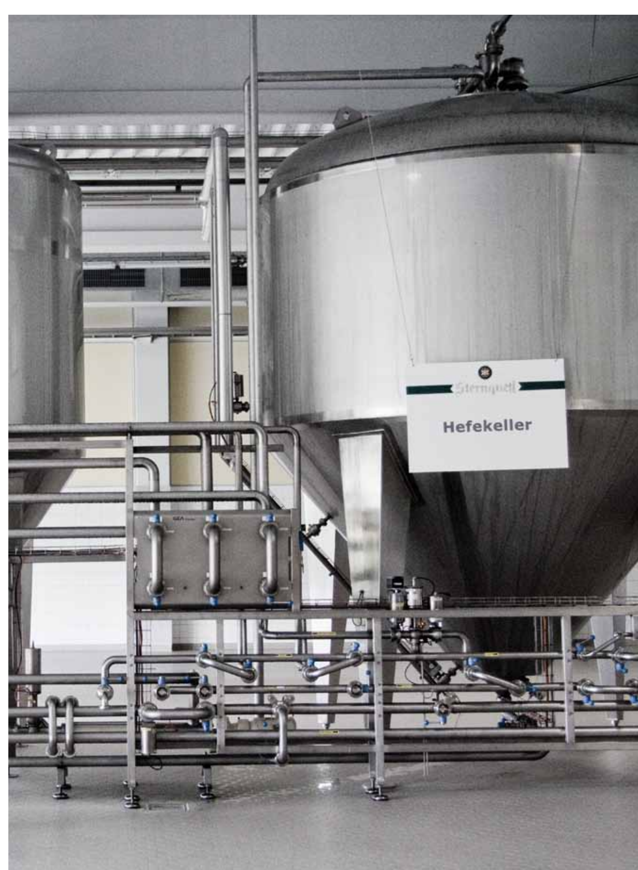
Bild Links: Hefekeller ein Teilbereich der Kombitankstation, wo während der Gärung Kohlendioxid natürlich entsteht
