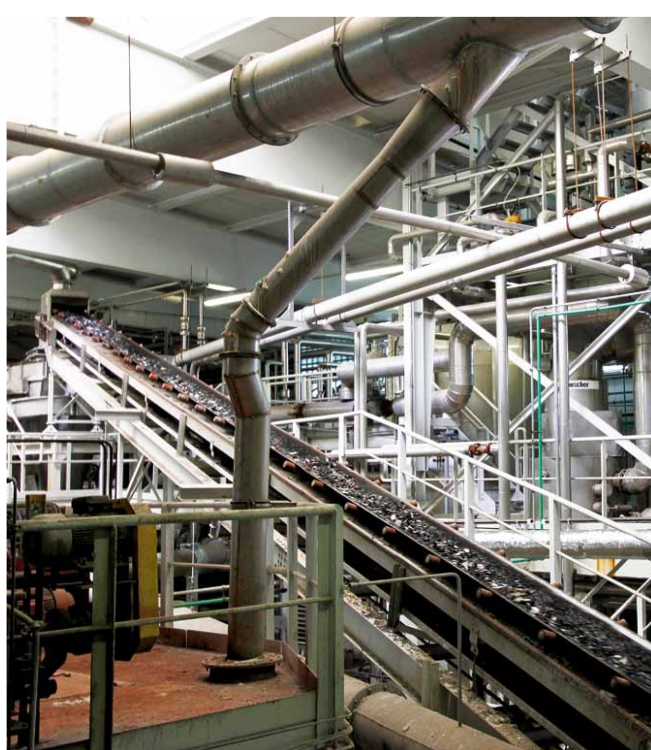
Batteriaufbereitung Hier erfolgt die Zerlegung und Trennung der Bleibatterie in ihre Einzelteile
